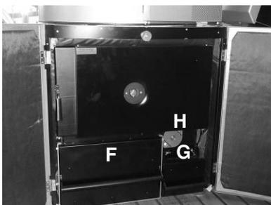
8) Dévisser les orifices de nettoyage (H) et retirer les cendres sous la grille.
