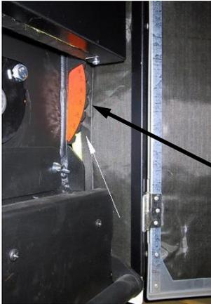
Après chaque changement de combustible ou après chaque arrêt prolongé de l'installation, il faut vérifier le réglage de l'air de combustion, resp. le régler à nouveau.
